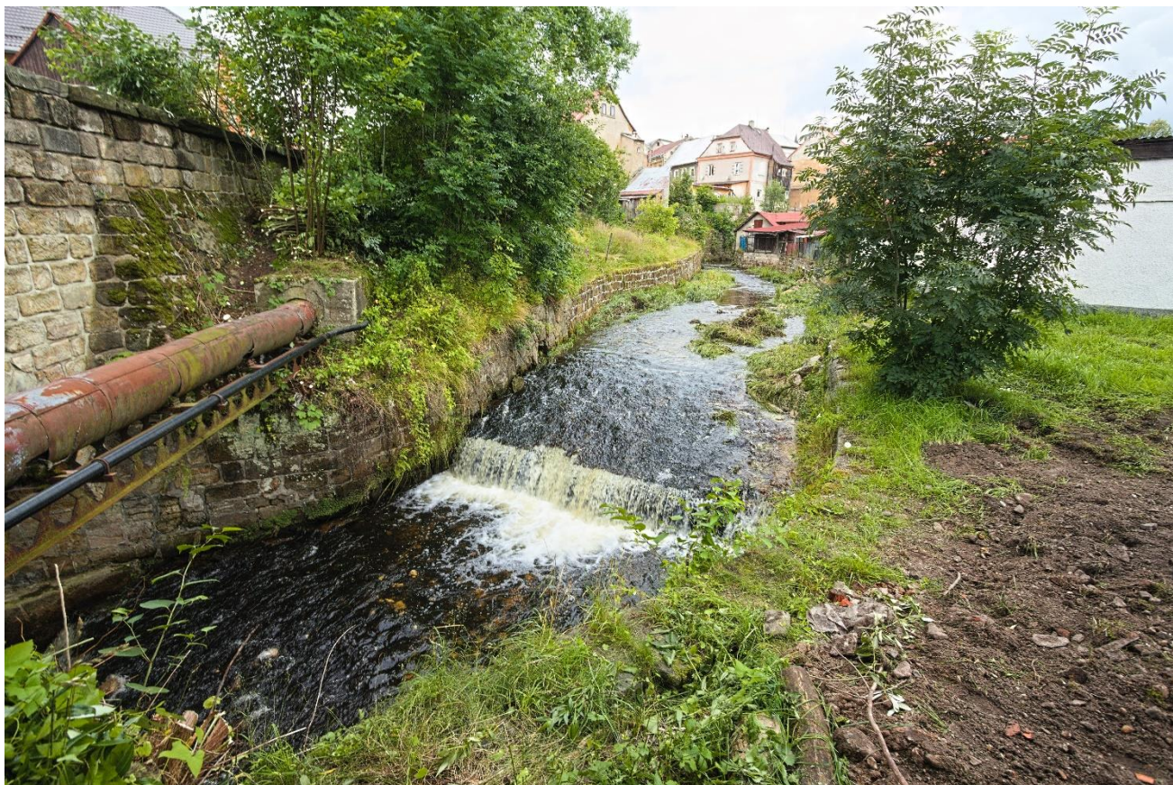
Foto č. 7 – Pohled o mostu proti proudu. Oprava pravobřežní zdi od mostu cca 10 m nad stupeň, kde zed' přechází do řádkového zdiva z pískovce.
